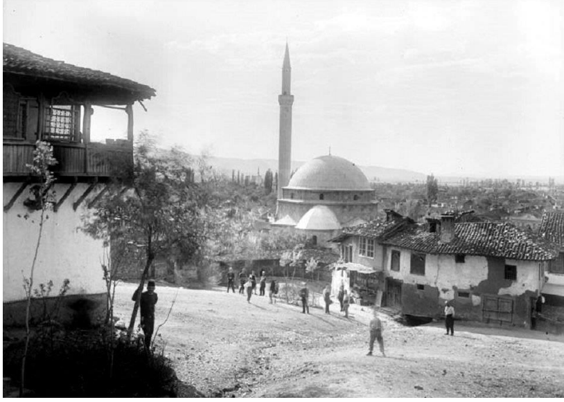
EK Foto. 1: 19. Yüzyıl'da Prizren, Sinan Paşa Camii Mevkii (Besa Kastrati Arşivi'nden 2019).
