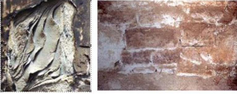
Resim 94. Yapraklaşma (sol) ve tuzlanma (sağ)
