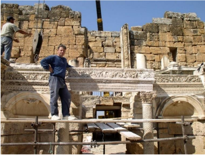
Resim 147. Hierapolis antik kenti tiyatro restorasyon çalışmaları sırasında statik ve estetik olarak üretilip eklenen parçalar (M. Cura)
